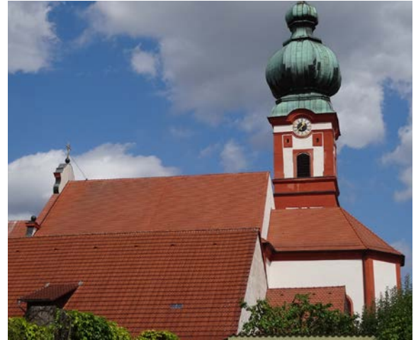
reizvolle und ungestörte Dachlandschaft
