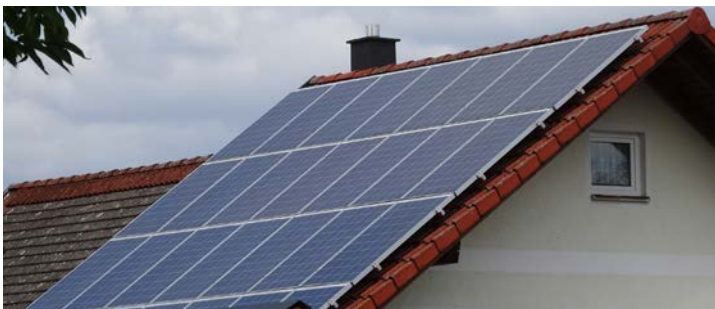
dachverträgliche Anordnung von Solaranlagen
